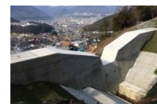
土砂災害防止施設
